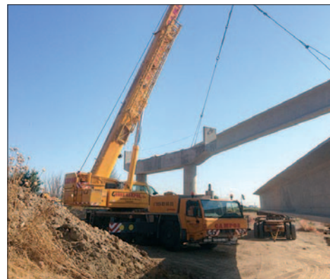
Los trabajos de la circunvalación continúan su curso. LVDT.
