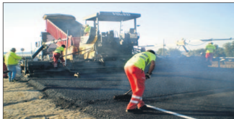
Los operarios durante los trabajos en el firme de la vía.
