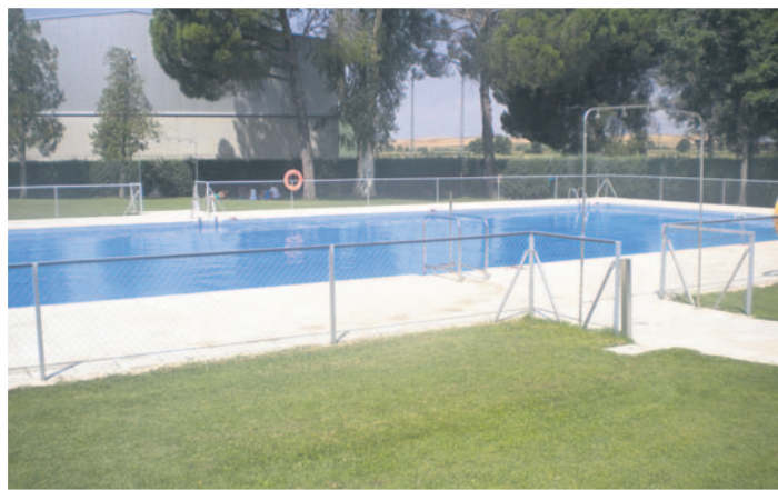
El vaso de la piscina municipal ha sido reparado.
