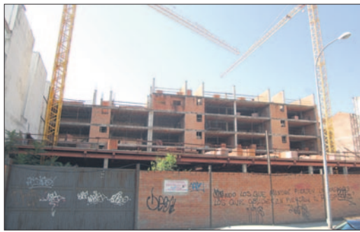
La propiedad podrá continuar, por fin, con las obras del edificio.
