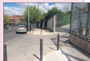
Resultado de las obras en Toledo. LVDT.
